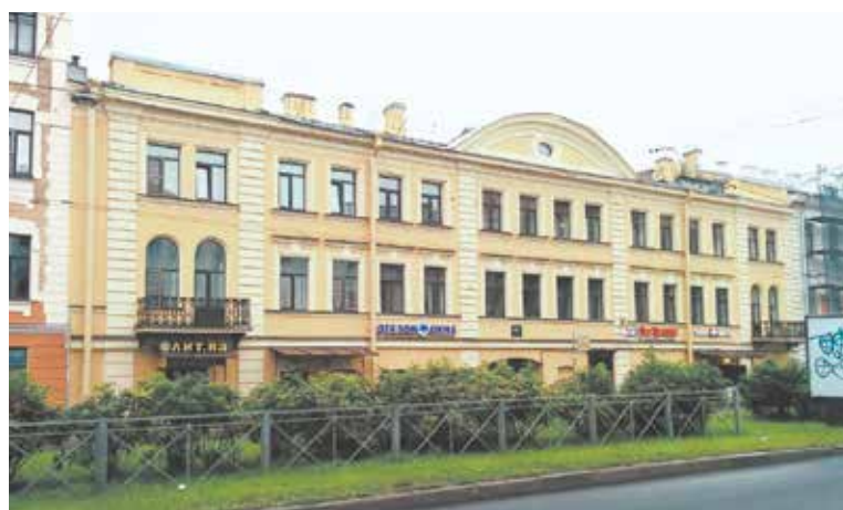
Собственный дом купцов Чиркиных — Малый пр. В. О., 5. Современный вид
