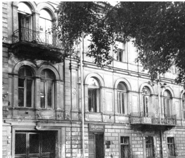
Здание библиотеки им. Л. Н. Толстого на Большом пр., д. 10
