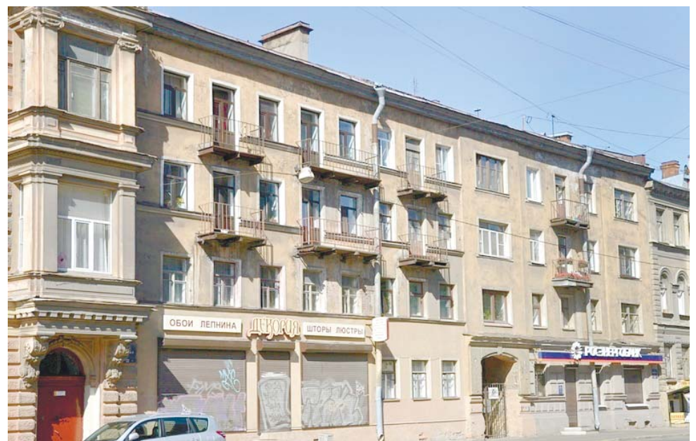
За фасадом этого здания, тогда еще двухэтажного и не перестроенного, находился дом, в котором жила Анна Керн
